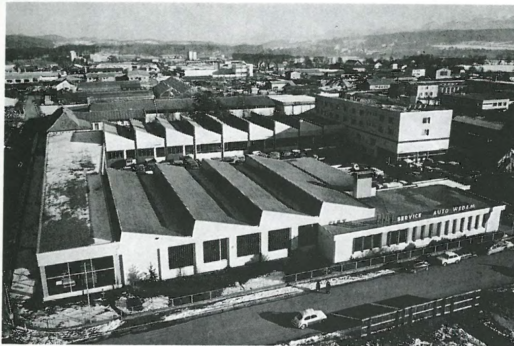
LKW-Zentrum und Ersatzteillager
